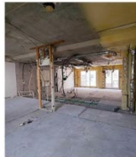
解体済み室内
