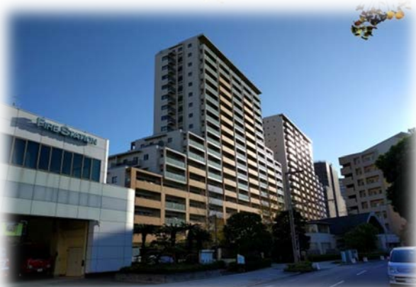
存在感のある高層棟(E棟 & D棟)
